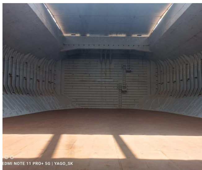
02 / Vista interna do porão sem carga visível.
